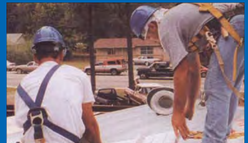
20. Install Ridge Cap
