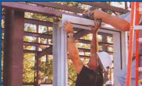
12. Install Door Frame
